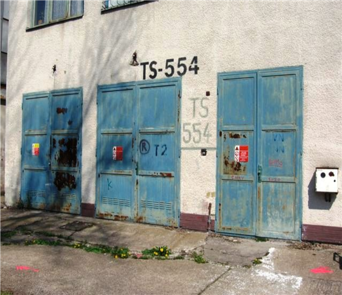
budova transformačneje stanice
