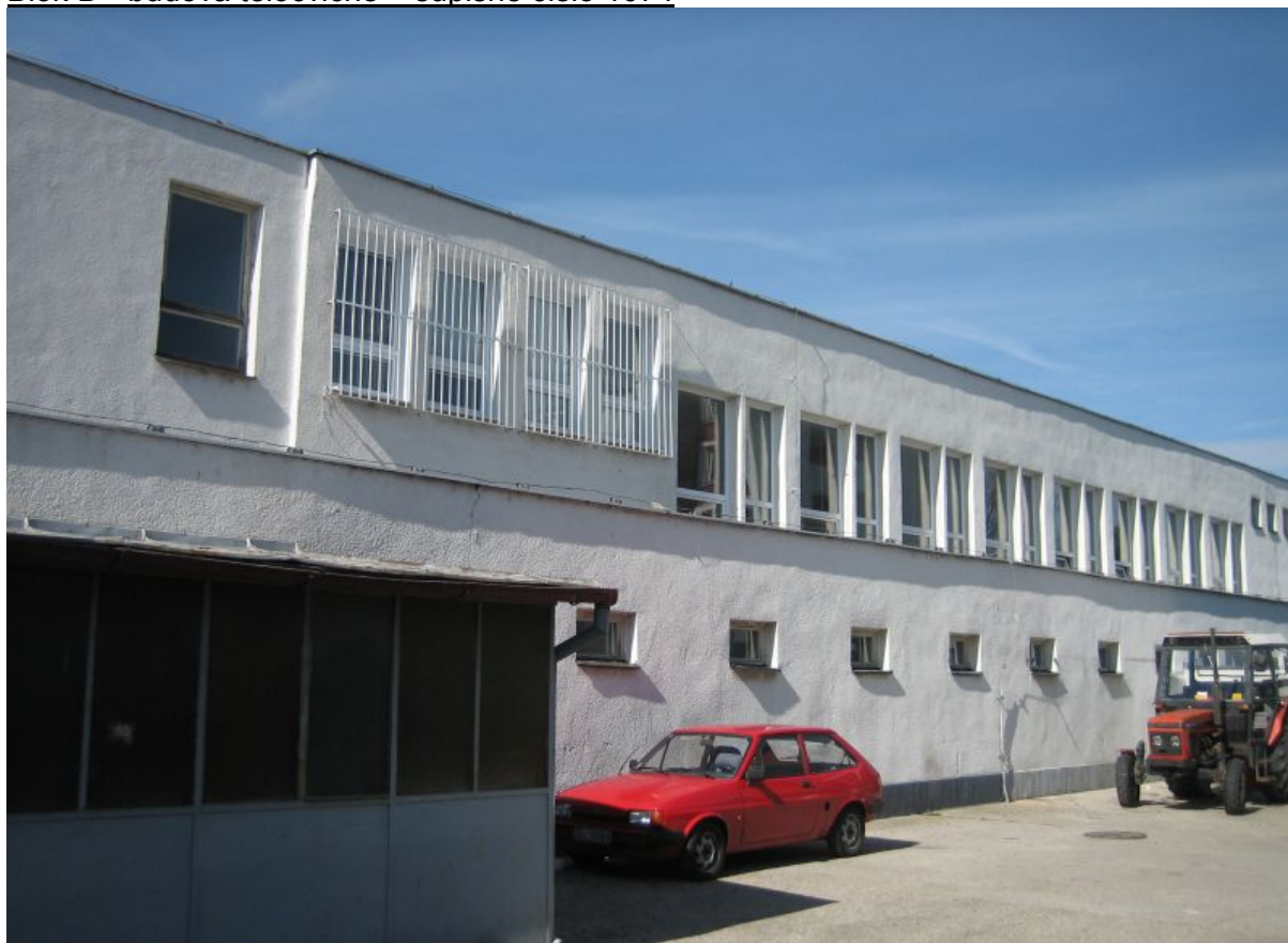
Blok D - budova telocvične – súpisné číslo 1074
