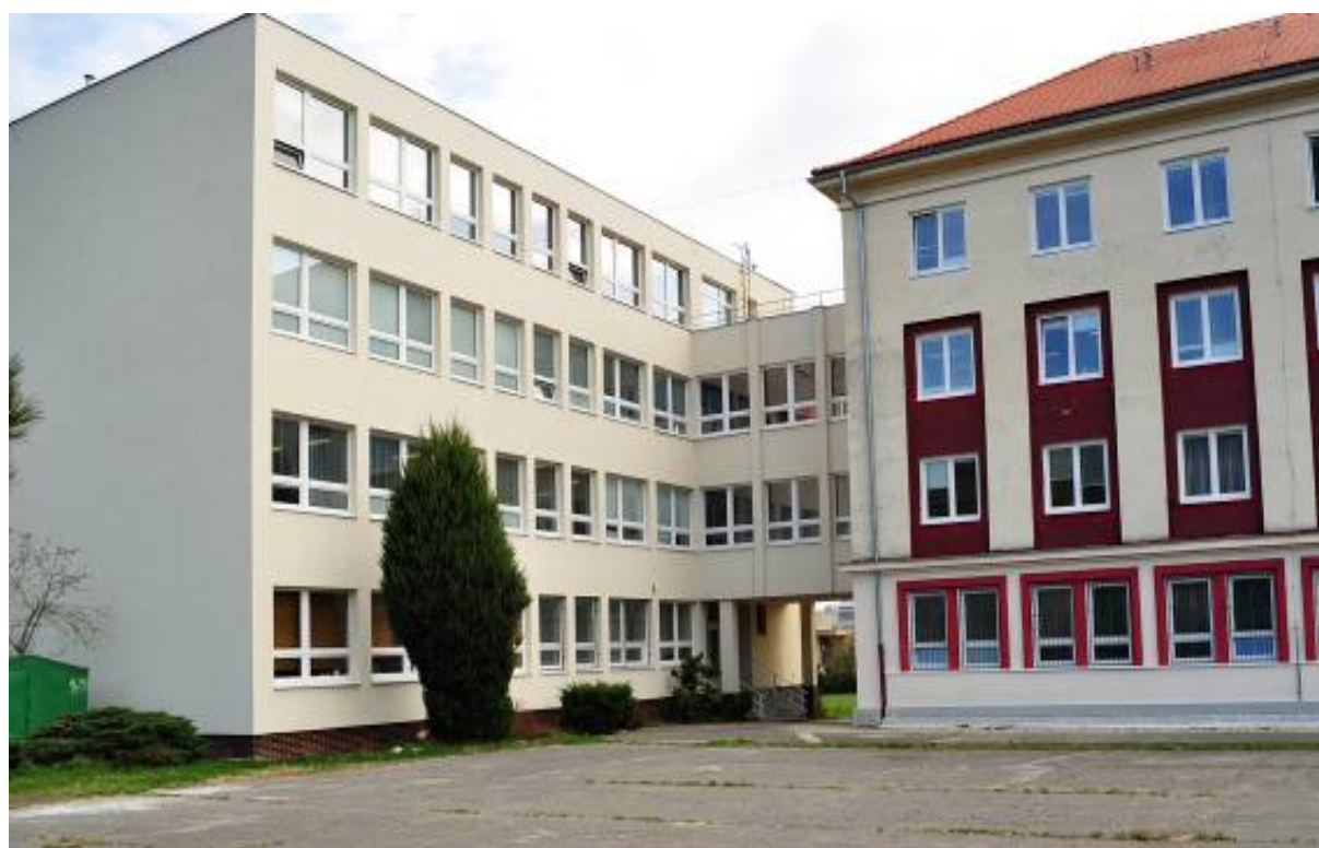
Ostatné stavby - prístavba, súpisné číslo 1531
