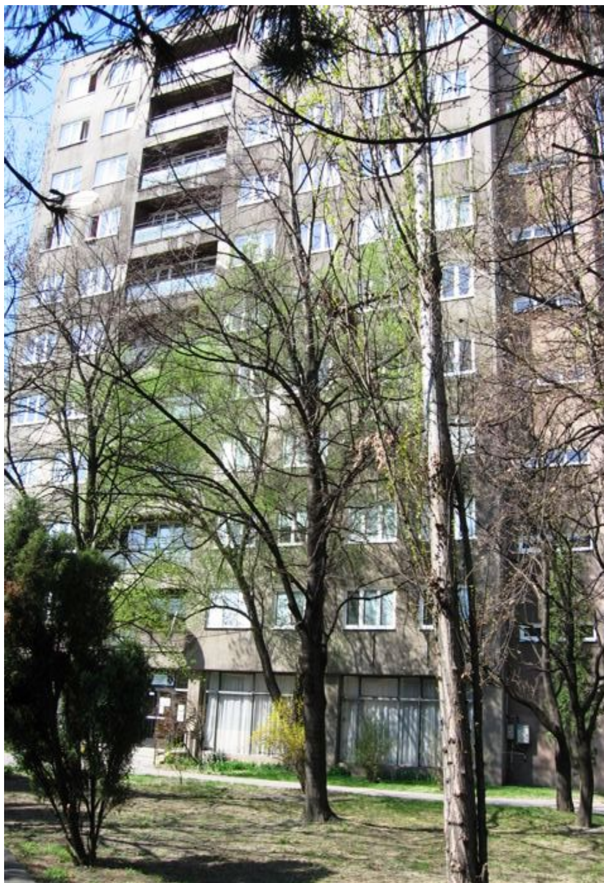
budova školské internátu – Vranovská 2
