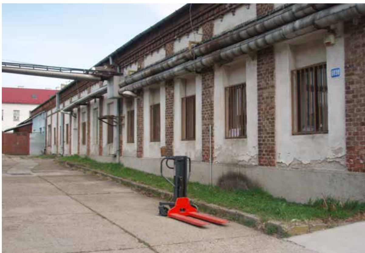
"Budova B-3" súpísne číslo: 6038-telocvična, (parcelné číslo: 2667/6)
