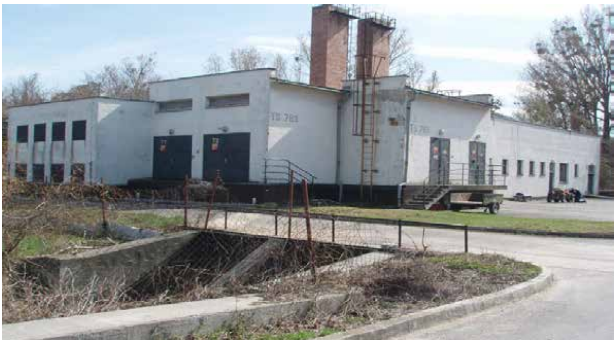
"Budova T" súpisné číslo: 6013- ÚSS pre TPM- kotolňa a trafostanica, (parcelné číslo: 2663)
