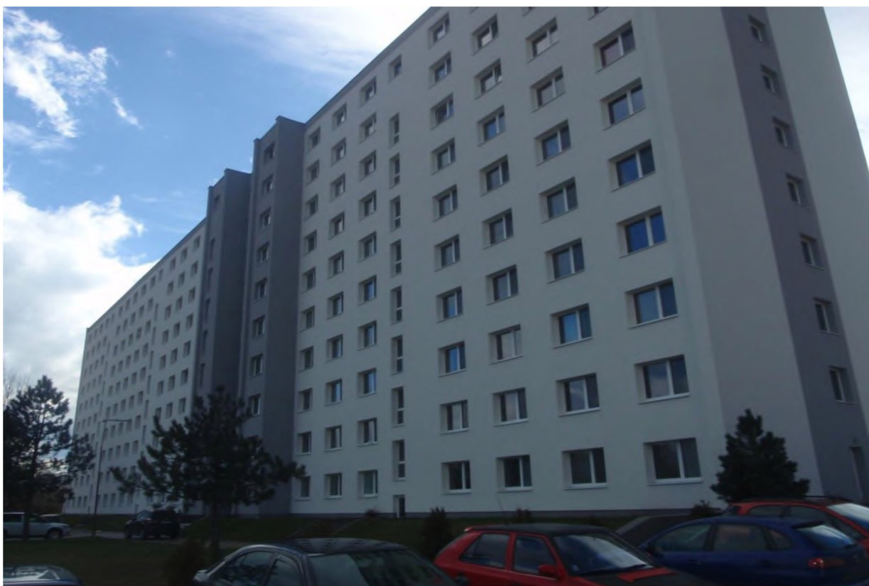
(vestibul, južný pohľad – budova internátu)
