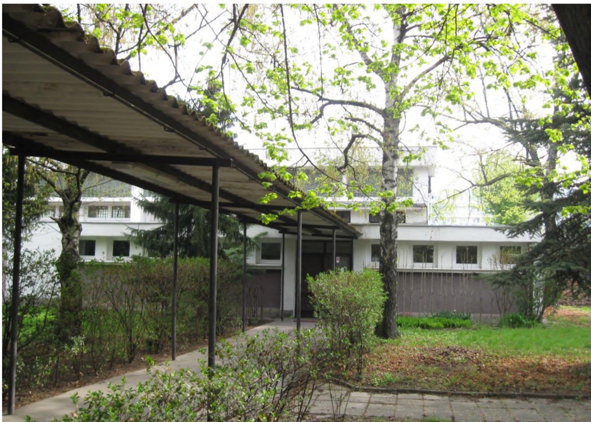
Budova mechanickej dielne na Nobelovej ul. 34 (súpisné číslo 3446)
