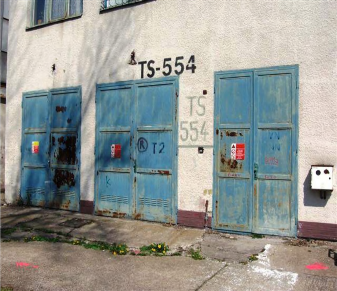
budova transformačnej stanice
