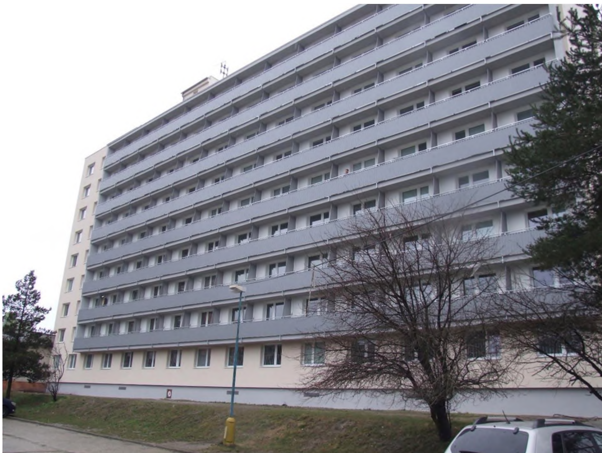
areál v Záhorskej Bystrici – budova školy
