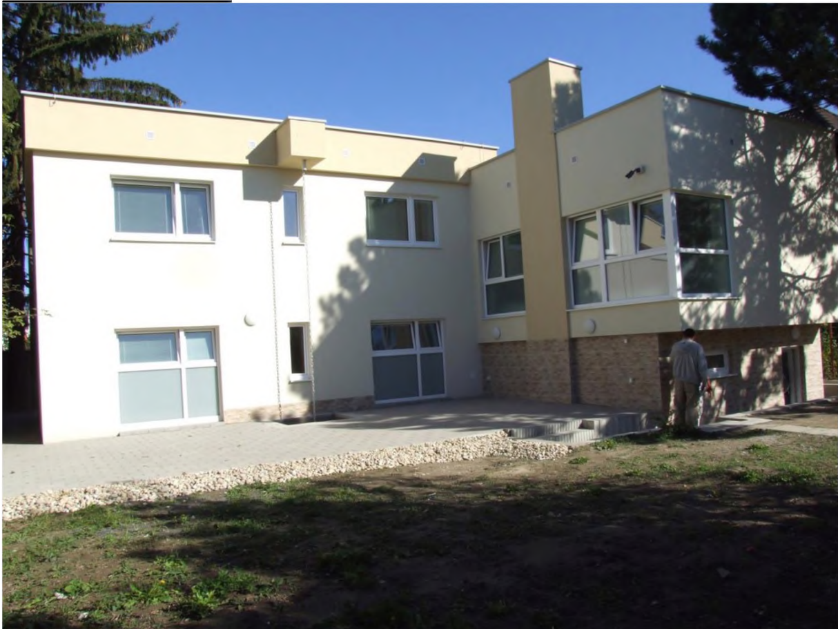
budova na Kl'ukatej ul. 36
