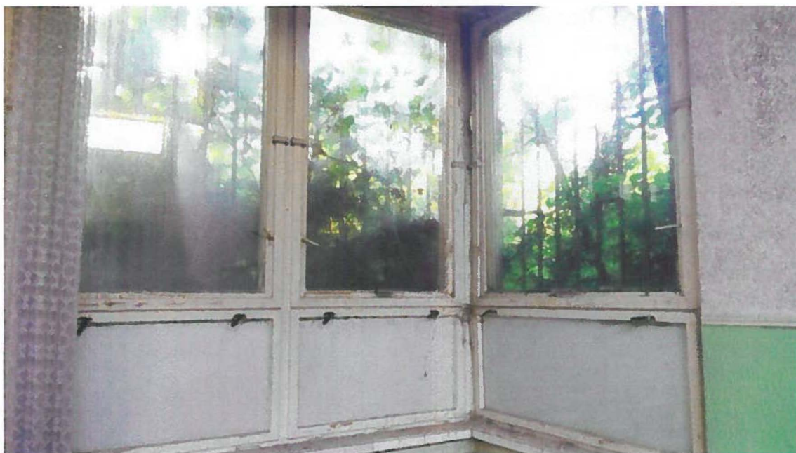
Obr. 3 Detail na okná a plesnivú bočnú stenu v jedálni.
