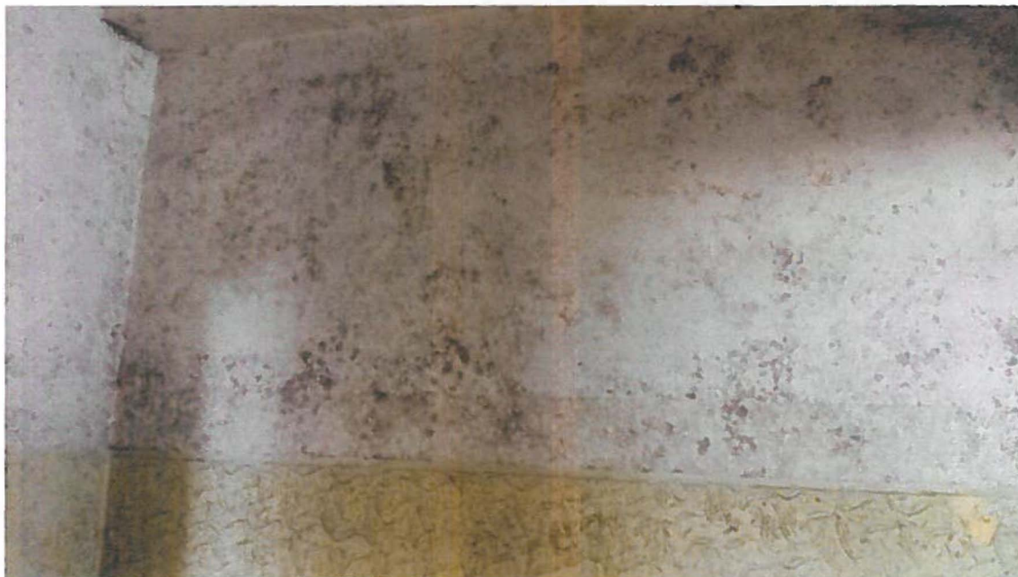
Obr. 7 Stena skladu napadnutá plesňou
