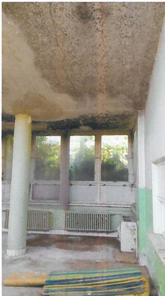
Obr. 2 Plesne na streche pri výdajni stravy z kuchyne
