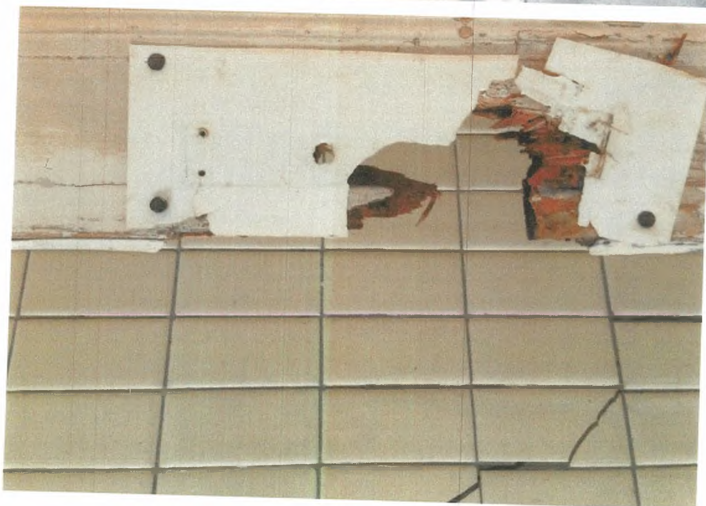
Väčšina dverí v objekte má vylámané zámkové vložky
