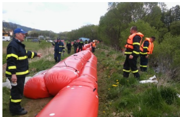
Obr. 60: Mobilná protipovodňová bariéra
