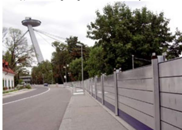
Obr. 59: Mobilné protipovodňové zábrany v Bratislave
