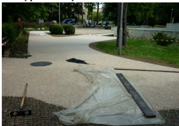
Obr. 96: Plne pochôdnny vodopriepustný povrch – Mestský park Piešťany
