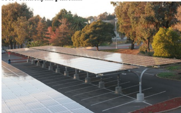
Obr. 22: Zatiernenie parkoviska pre autá fotovoltaickými panelmi
