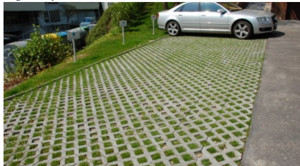
Obr. 9: Parkovisko v Bratislave z betónových vegetačných tvární
