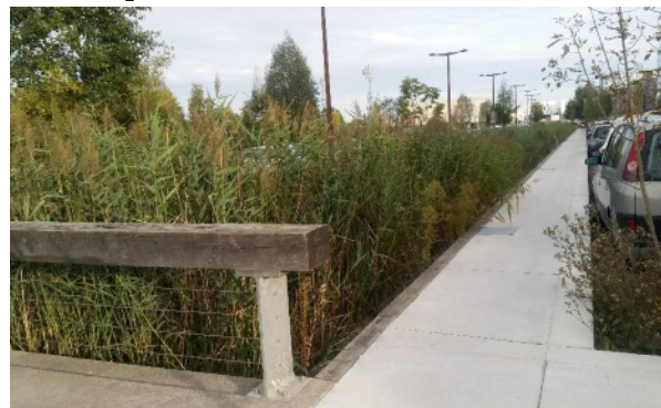
Obr. 72: Vsakovacia a retenčná plocha v urbanizovanom prostredí
