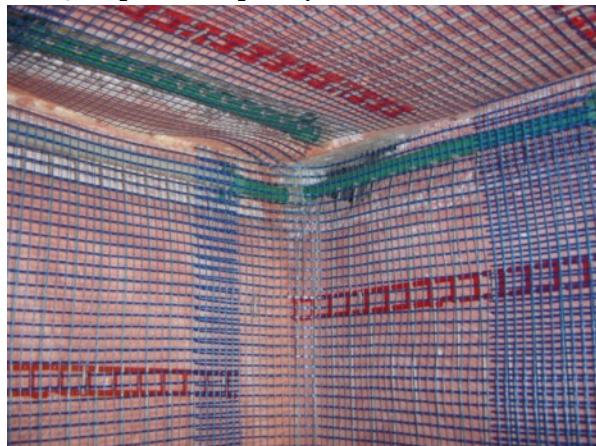
Obr. 50: Aplikácia kapilárnych rohoží
