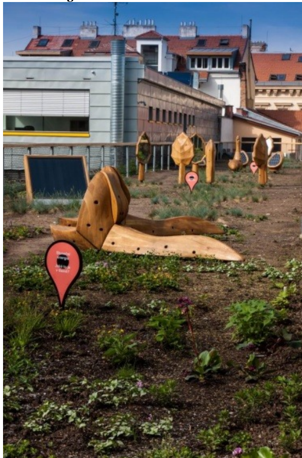
Obr. 80: Vegetačná strecha na budove C
