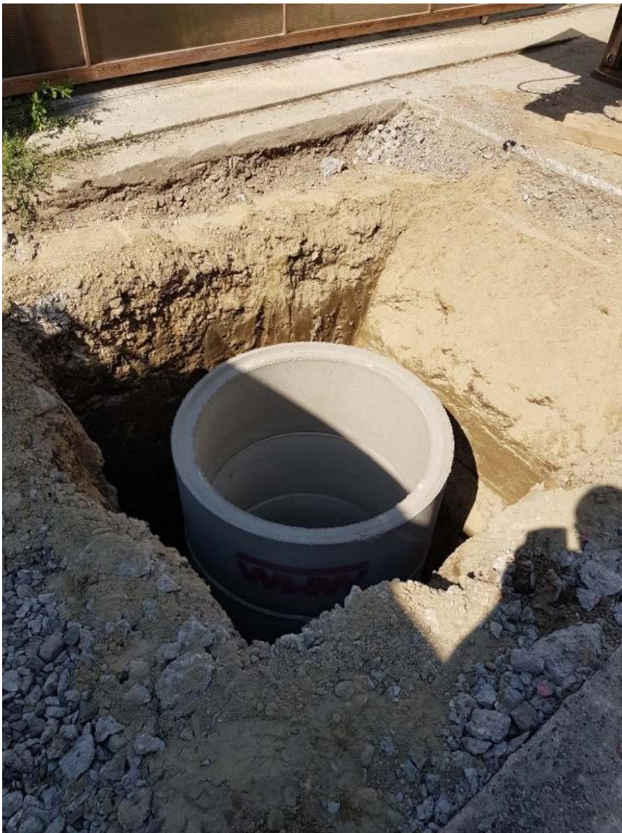
Obrázok č. 5: Protipovodňové úpravy v obci Zálesie – Lesná ulica - osadenie skruží
