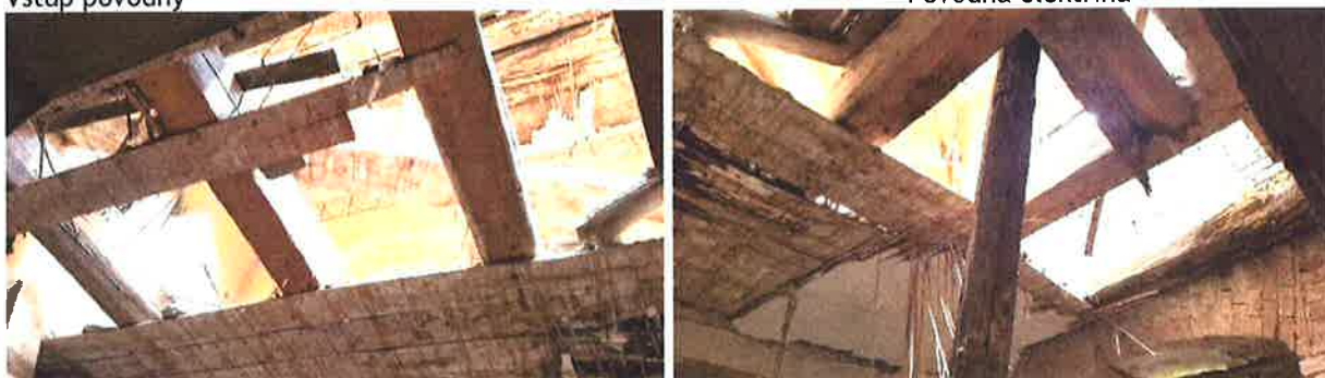
Stropná konštrukcia nad 1.np - vstupná časť
