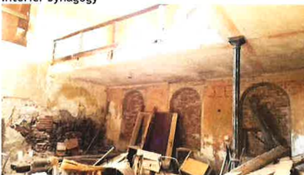
Strop nad 1.np
