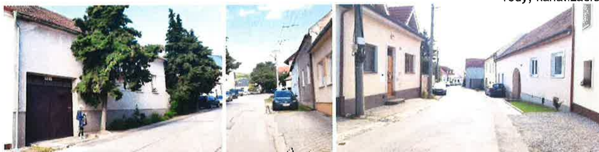
Pezinská ulica č. 21 - prístup cez dvor
