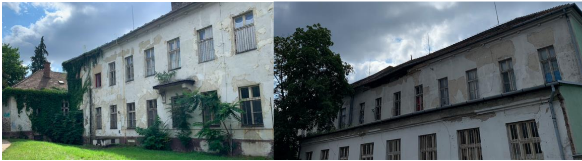
Obr.4.: Havarijný stav budovy v nájme Odborného učilišťa
