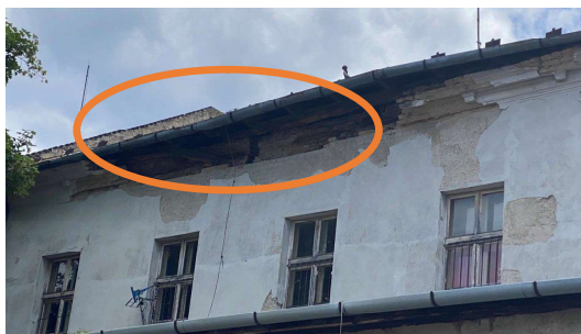
zistenie pokračovania poruchy – vypadnutie nadmurovky
