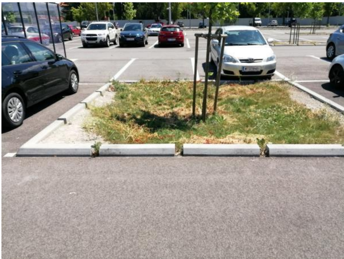
Obrázok 15-13 Odvodnenie parkoviska do vsakovacej jamy so zeleňou (Zdroj: Spracovateľ)
