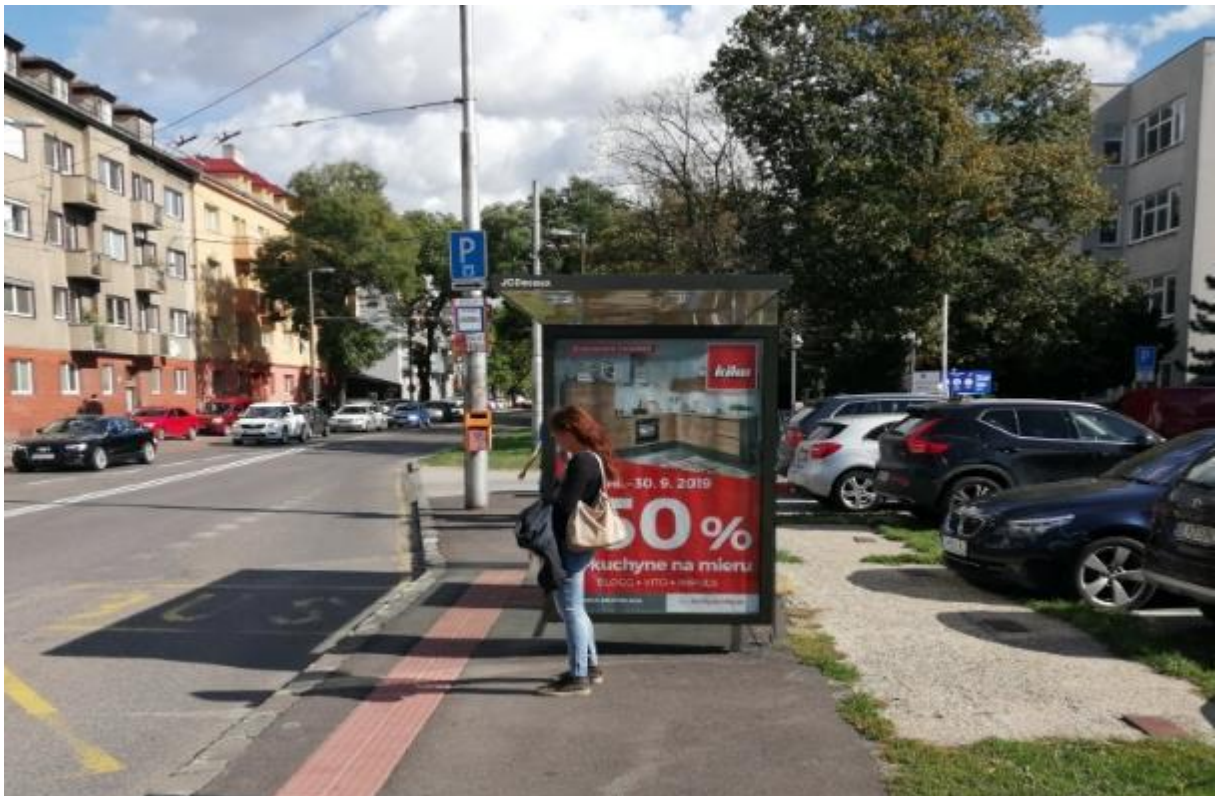
Obrázok 12-3 Nevhodne umiestnený prístrešok na zastávke MHD. Pritom je priestor na jeho umiestnenie za hranou chodníka. Zároveň je aj nevhodné prevedenie prístrešku s nepriehľadnou bočnou stenou vyplnenou reklamou na strane prízjazdu vozidla MHD (Zdroj: Spracovateľ)
