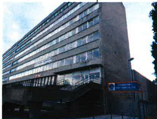
Budova SOU s.č.1899 na parc.č.17063/18:
