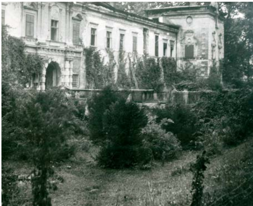
Neupravená zeleň v priekope kaštieľa v Stupave v roku 1955. Foto: Štefan PISOŇ, 1955
