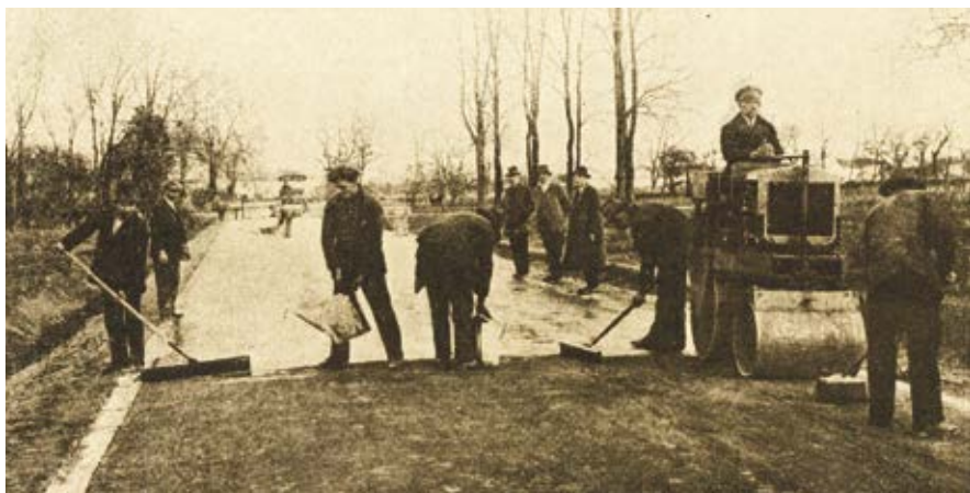
Povrch zo živичnej emulzie Collas na esenskom asfalte na župnej hradskej Bratislava - Komárno (z publikácie Pamätník župy Bratislavskej, Bratislava 1928)
