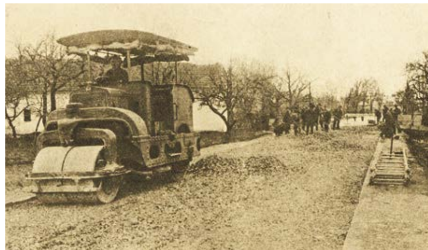
Penetrácia štrkovej vozovky essenským asfaltom na župnej hradскеj Bratislava - Komárno (z publikácie Pamätník župy Bratislavskej, Bratislava 1928)
