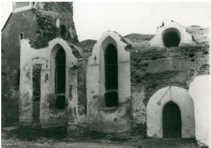
Prestavba kostola v Častej. Foto: Orbis, 1937. Zdroj: Archív PÚ SR
