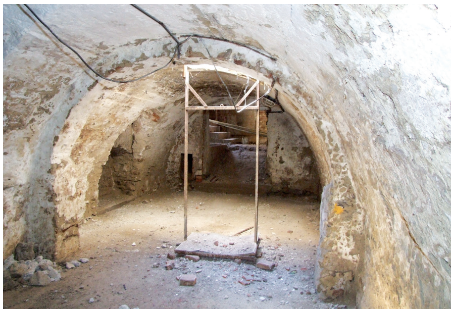
Suterén, pohľad od východu. Foto Z. Zvarová
