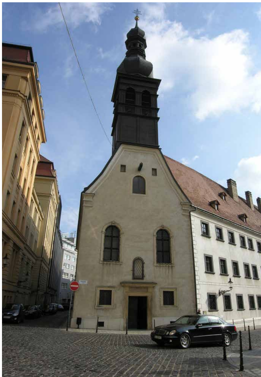
Bratislava, Kostol s kláštorom uršulínok - pohľad na hlavnú fasádu. Foto M. Belohorcová
