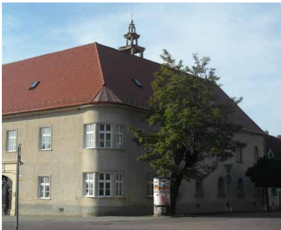
Rok 2013 – zmeny na objekte – vysoký krov, polkruhovú okná, kostolná veža. Foto B. Vorlíčková
