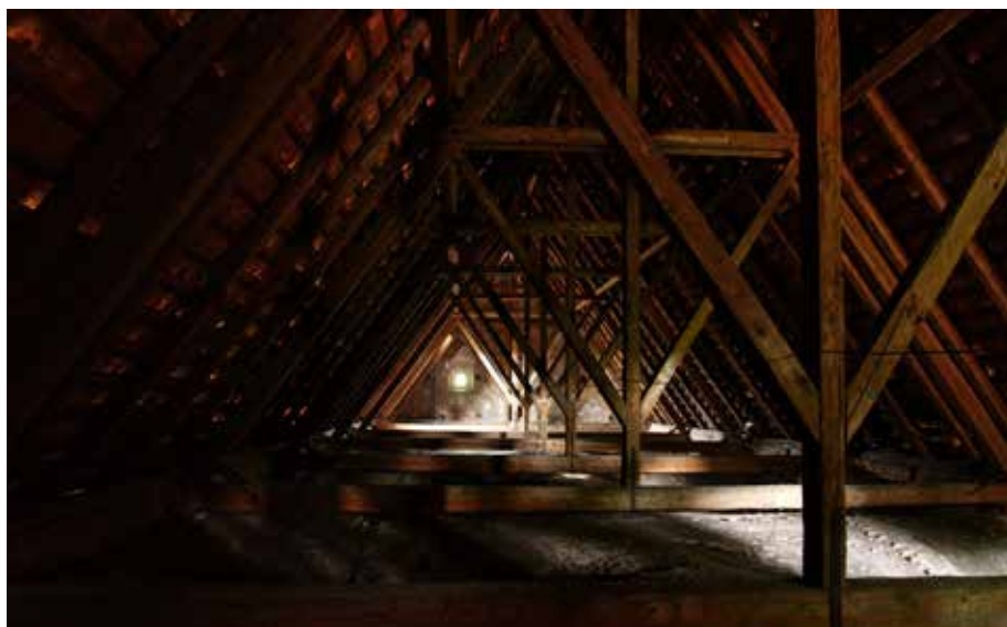
Krov lode, východný pohľad. Foto Jozef Tihányi
