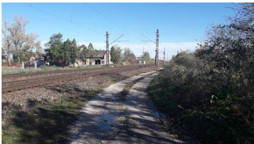
Obrázok 45 Jestvujúca nespevnená cesta pozdĺž železničnej trate v úseku Bernolákovo – Veľký Biel
