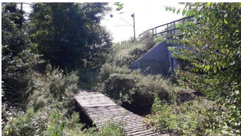
Obrázok 19 - Potrebné premostenie Suchého potoku pozdĺž železničnej trate. V súčasnosti je riešené preklopenie vodného toku formou paliet uložených na drevených hranoloch.
