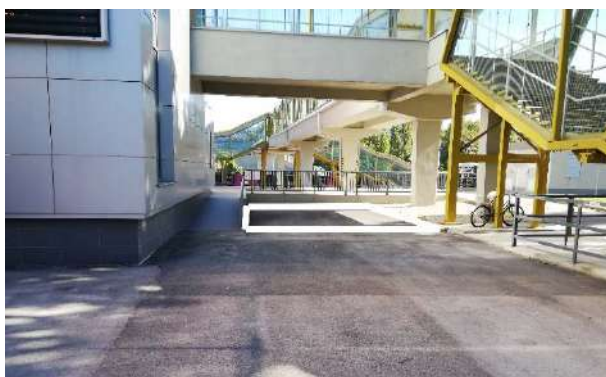
Obrázok 19 – Umiestnenie prístrešku pre bicykle pri budove železničnej stanice, s priamym prístupom na nástupište.
