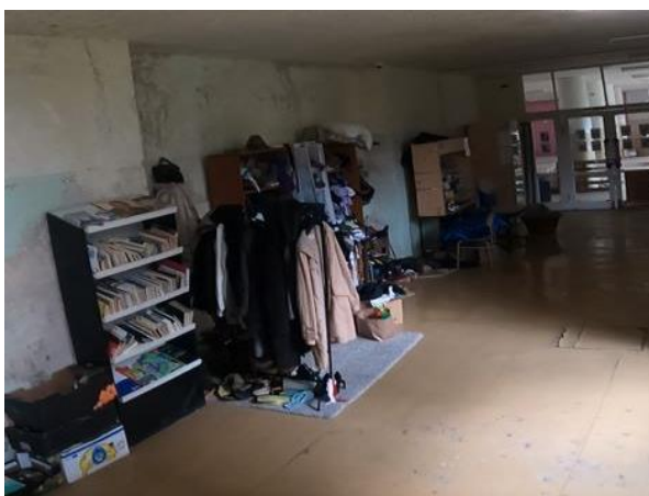
Obr. 42 B Chodba 1.NP (r. 2021).
