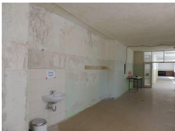
Obr. 42 A Chodba 1.NP (r. 2017).
