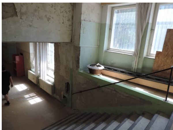
Obr. 44 A Schodisko 1.NP (r. 2017).
