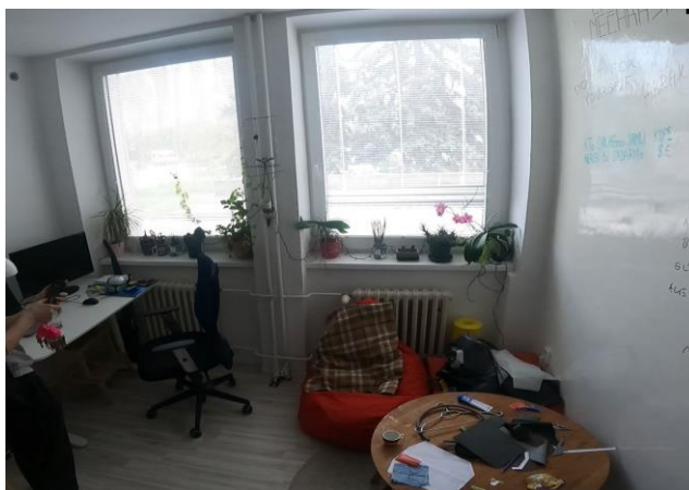
Obr. 39 Výmena okien a oprava podlahy miestnosť 1.NP (r. 2021).
