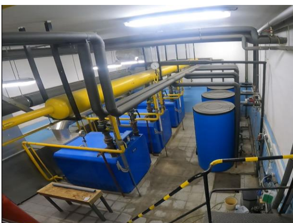
Obr. 49 B Kotelňa 1.NP (r. 2021).
