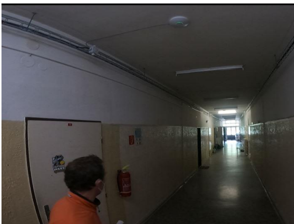
Obr. 36 B chodba 1.NP (r. 2021).
