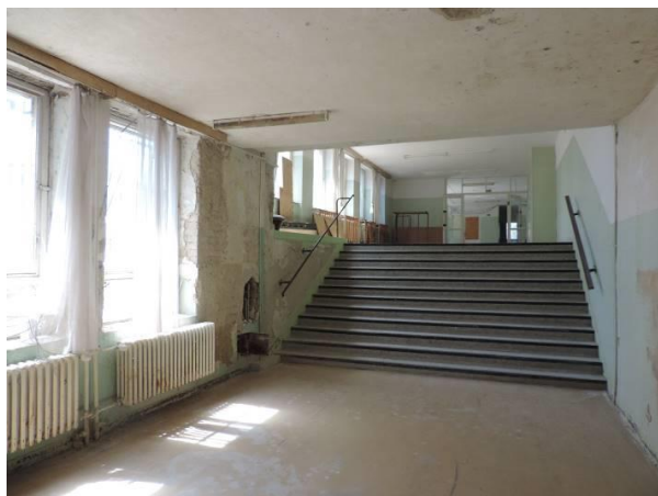
Obr. 43 A Schodisko 1.NP (r. 2017).
