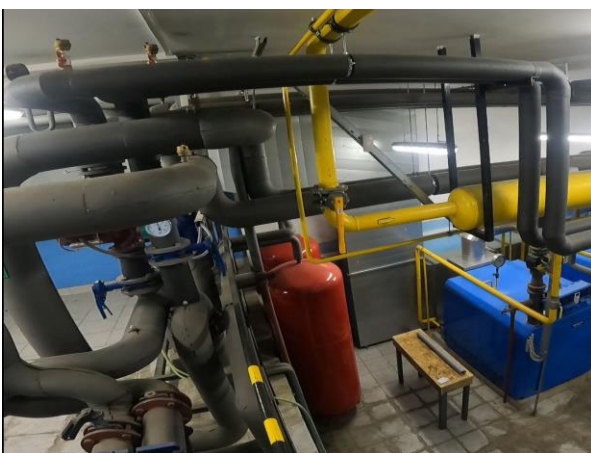
Obr. 48 B Kotelňa 1.NP (r. 2021).
