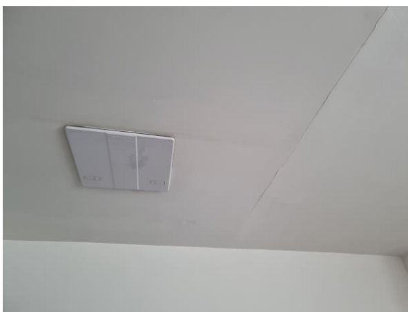
Obr. 37 B strop v miestnosti 1.NP (r. 2021).
