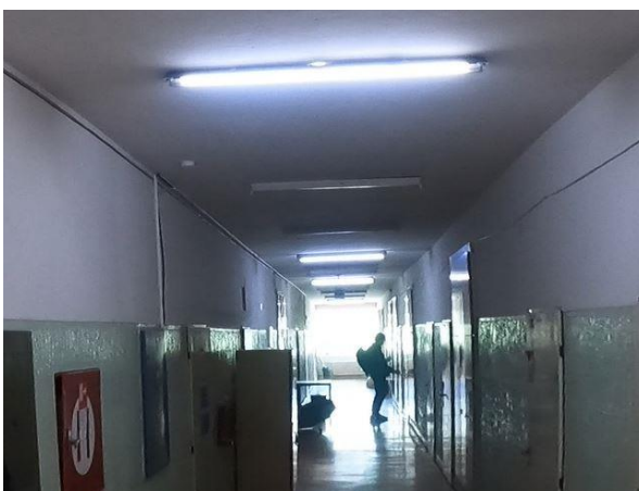
Obr. 27 B Chodba 3.NP (r. 2021).
