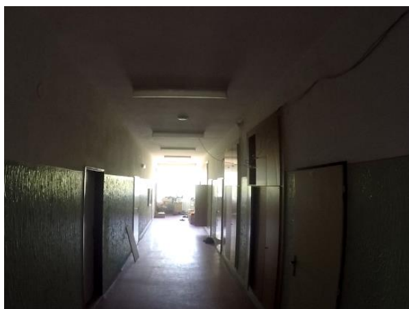
Obr. 27 A Chodba 3.NP (r. 2017).
