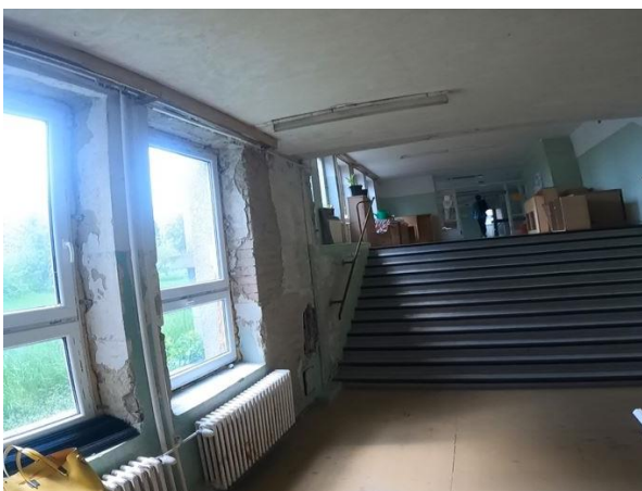
Obr. 43 B Schodisko 1.NP (r. 2021).
