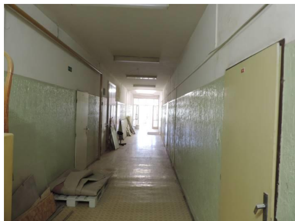
Obr. 41 A Chodba 1.NP (r. 2017).
