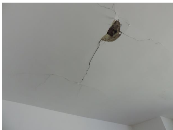
Obr. 37 A strop v miestnosti 1.NP (r. 2017).
