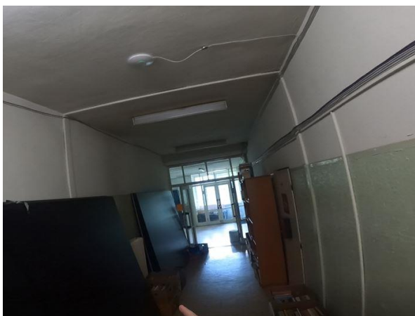
Obr. 41 B Chodba 1.NP (r. 2021).
