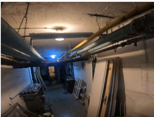
Obr. 47 B Suterén chodba 1.NP (r. 2021).
