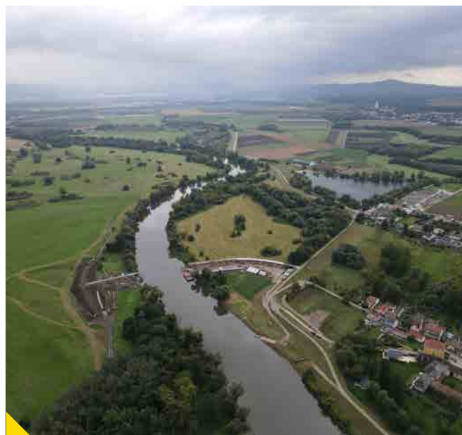
Výstavba nového cyklomosta
