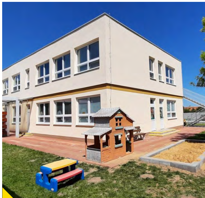
Prístavba a rekonštrukcia škôlky v Jablonovom, kde pribudlo 22 miest
