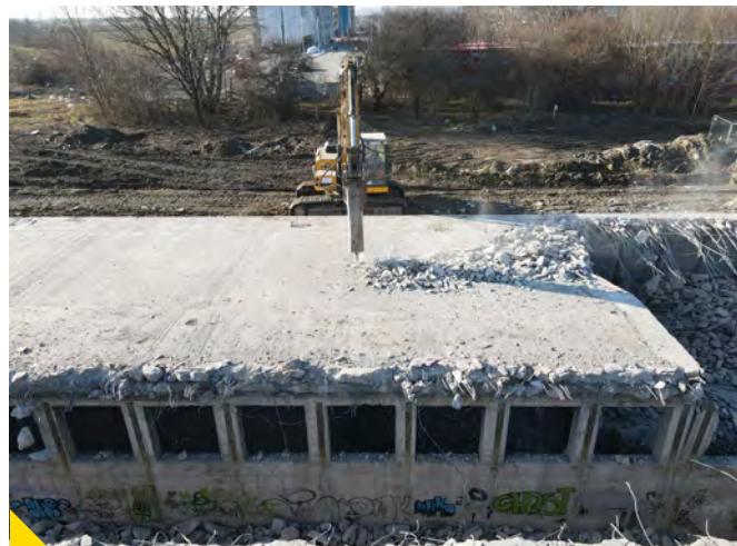
Búranie hrubej stavby bratislavského metra v Petržalke Foto: Michal Feik
