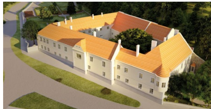
Kaštieľ a park v Modre; sídelná budova Malokarpatského osvetového strediska počas rekonštrukcie a vizualizácia po rekonštrukcii, 2019
