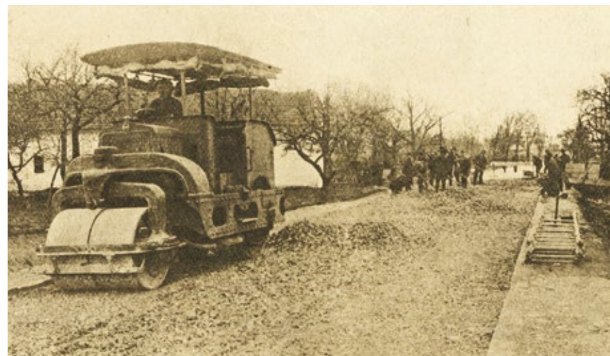
Penetrácia štrkovej vozovky essenským asfaltom na župnej hradskej Bratislava – Komárno (z publikácie Pamätník župy Bratislavskej, Bratislava 1928)
