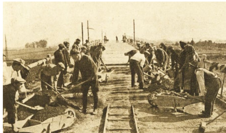
Práca na dvojvrstvovej betónovej vozovke pri Novom Meste nad Váhom (z publikácie Pamätník župy Bratislavskej, Bratislava 1928)
