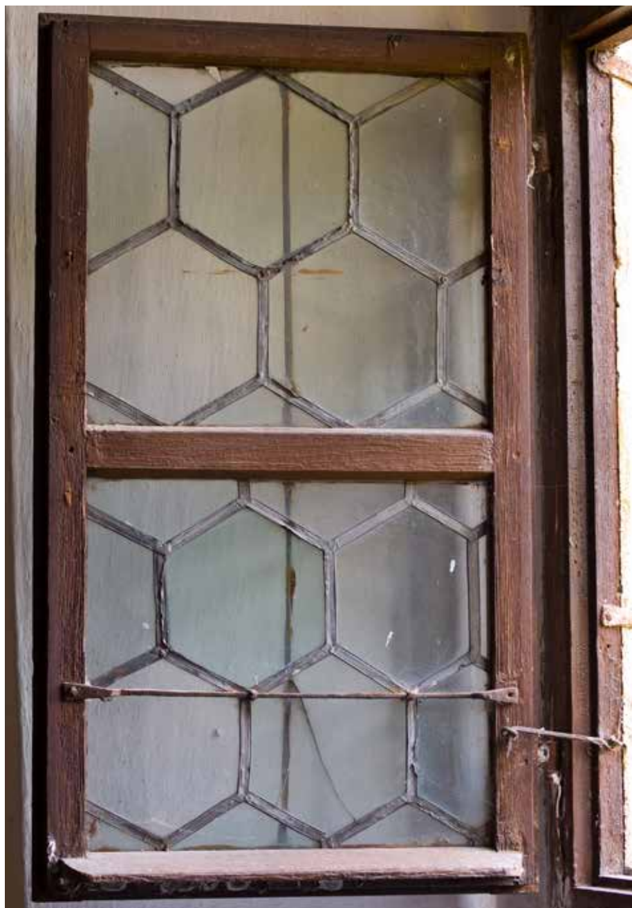
Detail okennej výplne okna južnej sakristie. Foto Jozef Tihányi
