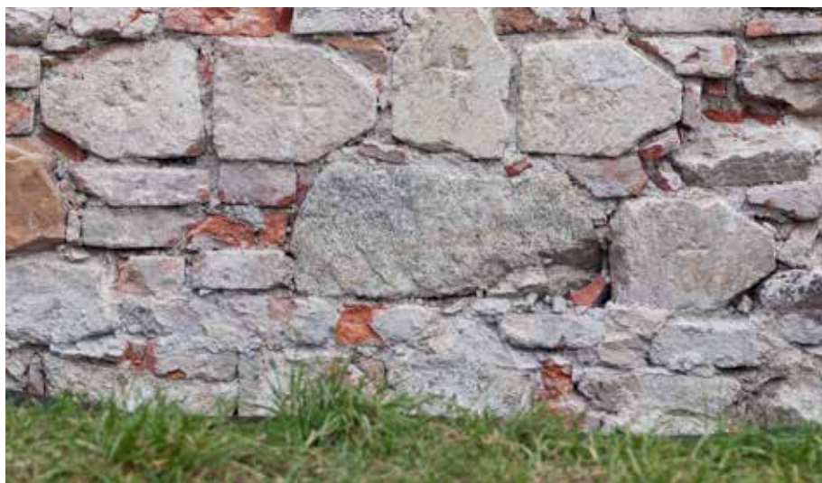
Rebrá gotickej klenby presbytéria, sekundárne využité ako murivo južnej sakristie. Foto Jozef Tihányi
