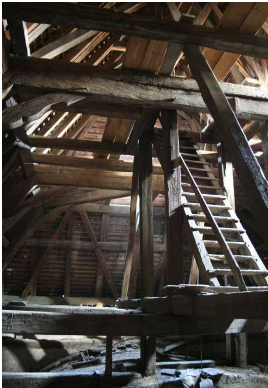
Pezinok, krov na kláštore kapucínov. Foto Krajského pamiatkového úradu Bratislava
