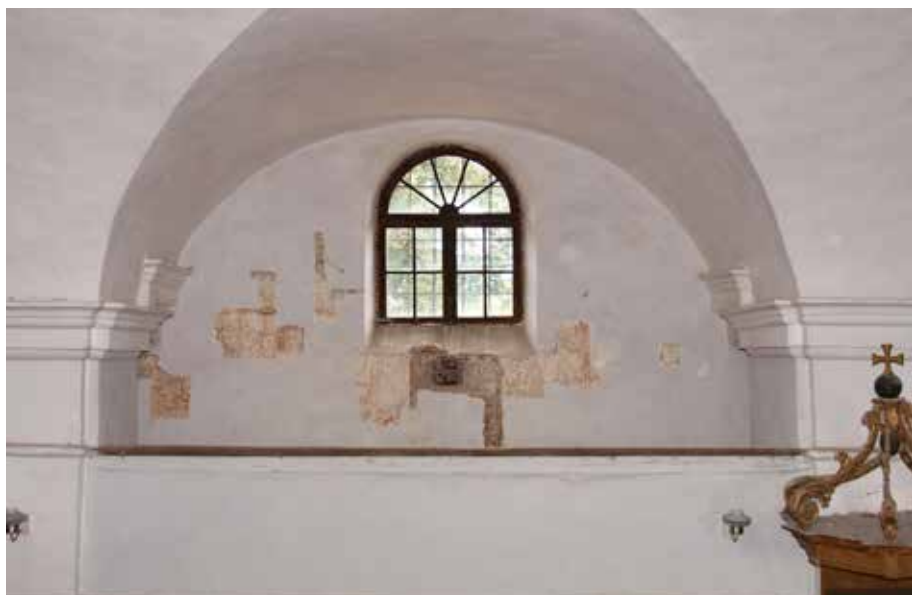
Situácia s nálezom malieb a zamurovaného okna v severnom múre lode. Foto Jozef Tihányi
