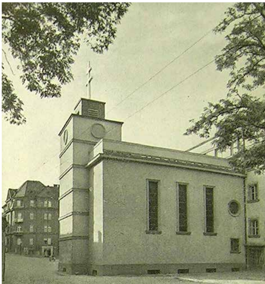
Kaplnka študentského domova Svorádov, pôvodný vonkajší vzhľad objektu. Reprofoto P. Buday, zdroj: Forum 1932
