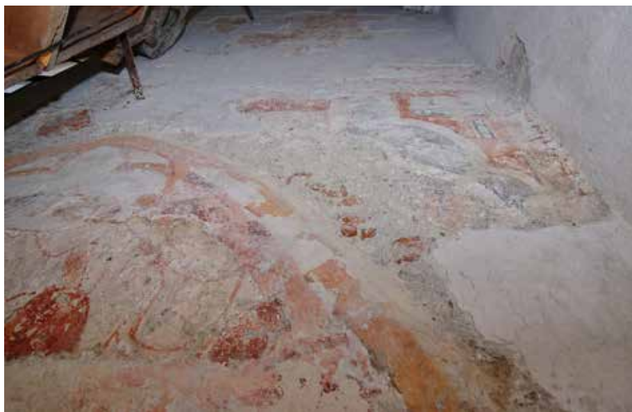
Situácia za severným bočným oltárom: nábehy baldachýnového oltára a dve vrstvy gotickej výmal'by. Foto Jozef Tihányi
