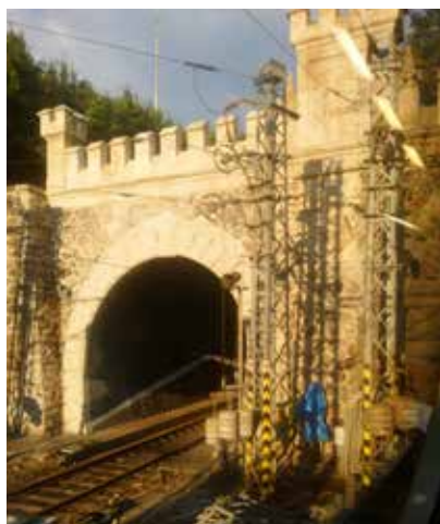
Bratislava-Staré Mesto, starý železničný tunel Foto: N. Kirinovičová, 2022
