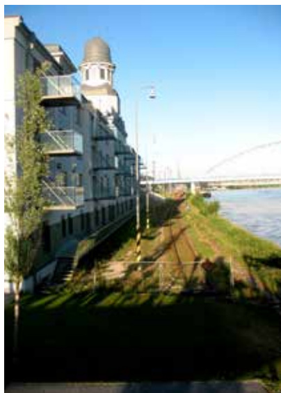
Pozostatky industriálnej zástavby – Sklad 7 s koľajiskom – inšpirácia pre návrh nábrežnej promenády (zdroj – 2)
