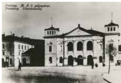
Podoba prijímacej budovy bratislavskej Hlavnej stanice po úpravách z rokov 1903 – 1905 (Zbierka ŽSR, Železničné múzeum SR)
