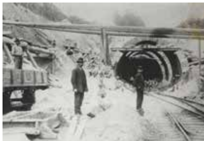
Práce na rekonštrukcii tunela medzi bratislavskou Hlavnou stanicou a Lamačom, rok 1901 (Archív mesta Bratislavy, Zbierka ŽSR, Železničné múzeum SR)
