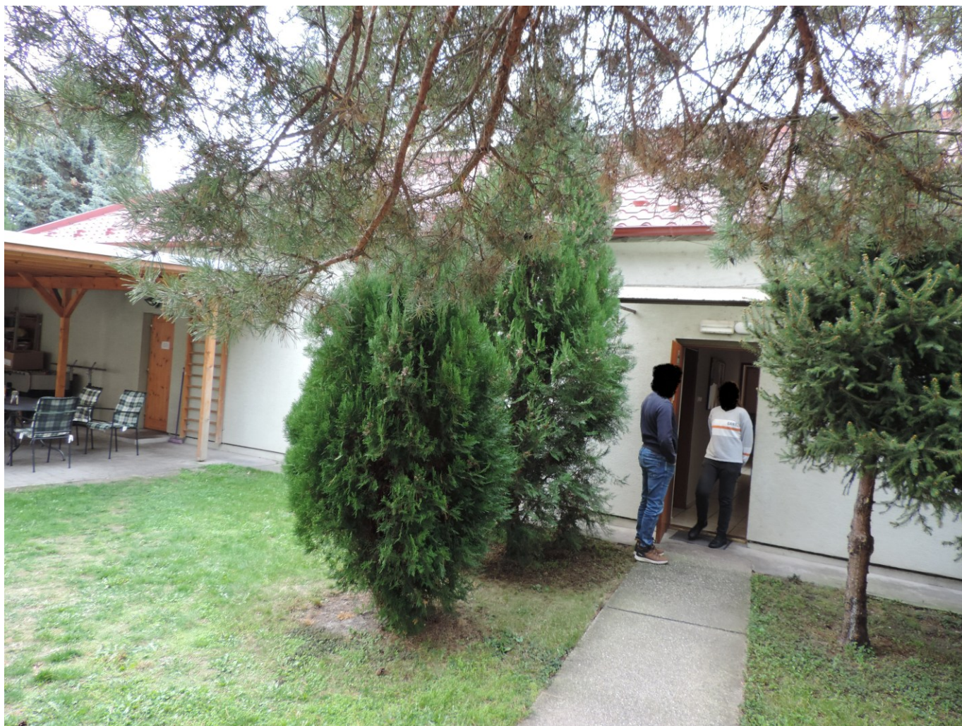
Pohl'ad Budova „B“ z vnútrobloku
