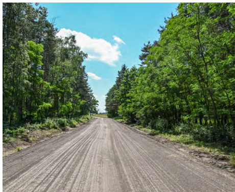
Rekonštrukcia cesty a mosta v obci Záhori na Záhori
