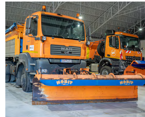
Zrekonštruovaná hala údržby v Malackách
