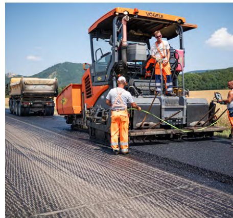
Rekonštrukcia cesty medzi II/501 pod Plaveckým hradom
