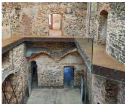
Hrad Helfštýn, sál v hradním paláci po plném zastřešení, 2022 ©NPÚ – František Chupík
