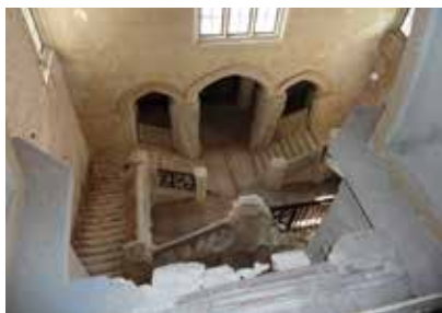
Vstupná hala s hlavným schodiskom Autor fotografie: Natália Ferusová
