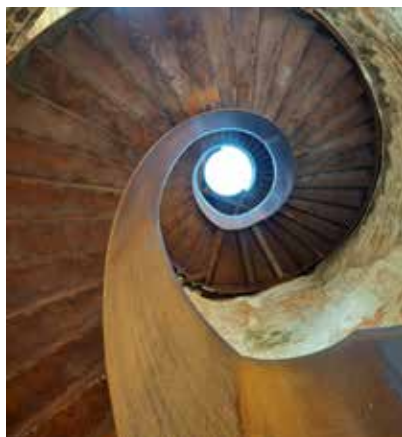
Hrad Helfštýn, nově vložené cortenové schodiště na západě, 2022 ©NPÚ – František Chupík
