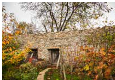
Rekonštrukcia mestského fortifikačného systému
